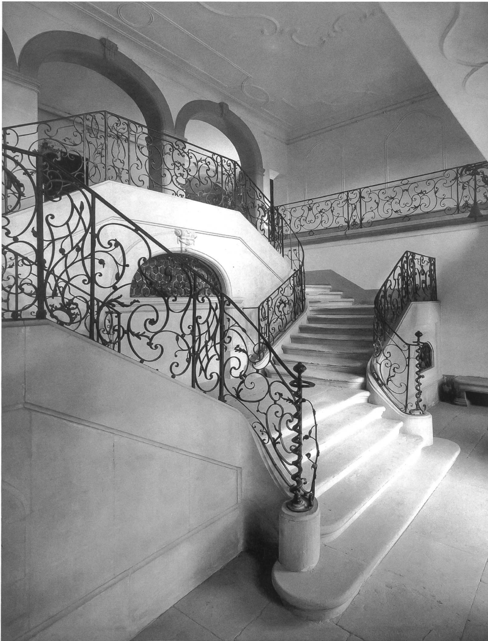
Abb. 105 Die Gitter der Ehrentreppe im Westflügel der Konventgebäude schmiedete Bruder Conrad 1768-1769.
