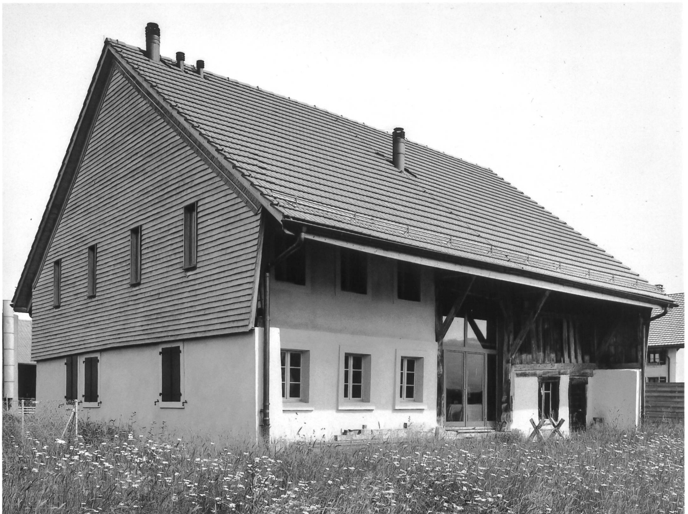
Fig. 19 Façade arrière et façade pignon de l'ancien logis. Le bâtiment n'est plus une ancienne ferme mais il n'est pas non plus un logement conventionnel.
