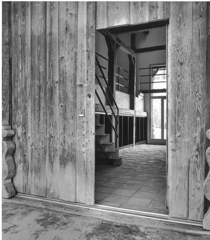
Fig 16 L'ancienne porte de grange, côté route, a été conservée et doublée de l'intérieur. La porte du logement y a été aménagée.
