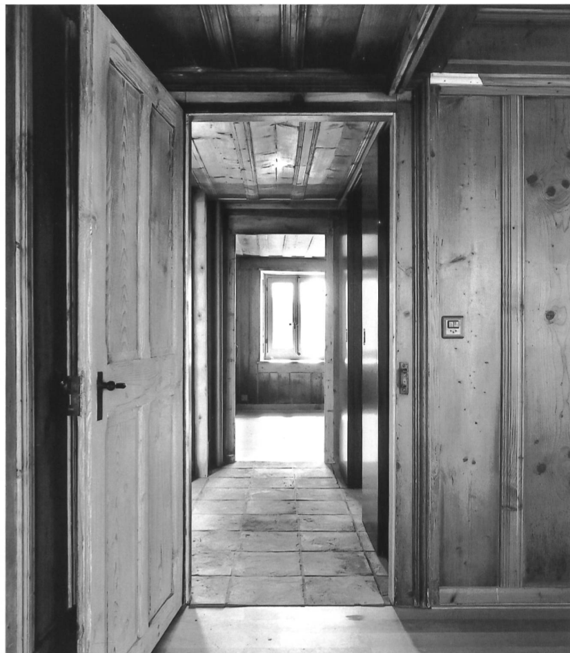
Fig. 2 Vue traversante de l'ancien logis au rez-de-chaussée – Les plafonds en bois, maintenus en place et soigneusement protégés, ont été utilisés comme coffrage. Les cloisons conservées ont été réparées en récupérant des éléments des cloisons supprimées.
