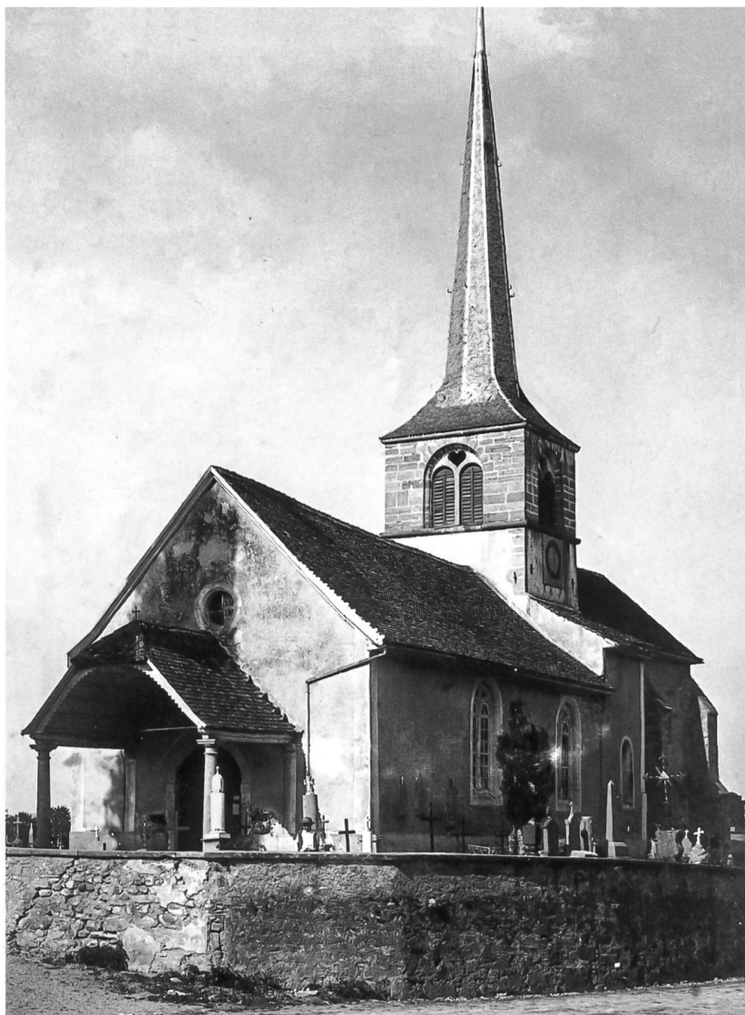
Fig. 3 L'ancienne église vue de l'ouest, avec la fameuse tour «de croisée». Clichés du professeur Joseph Zemp, probablement en 1901.
