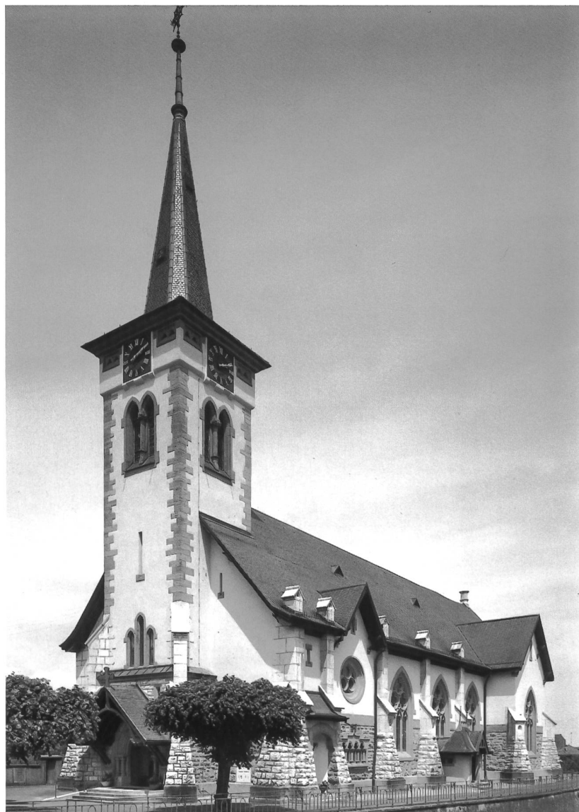
Fig. 11 Vue de l'ouest, avec la tour-porche.
