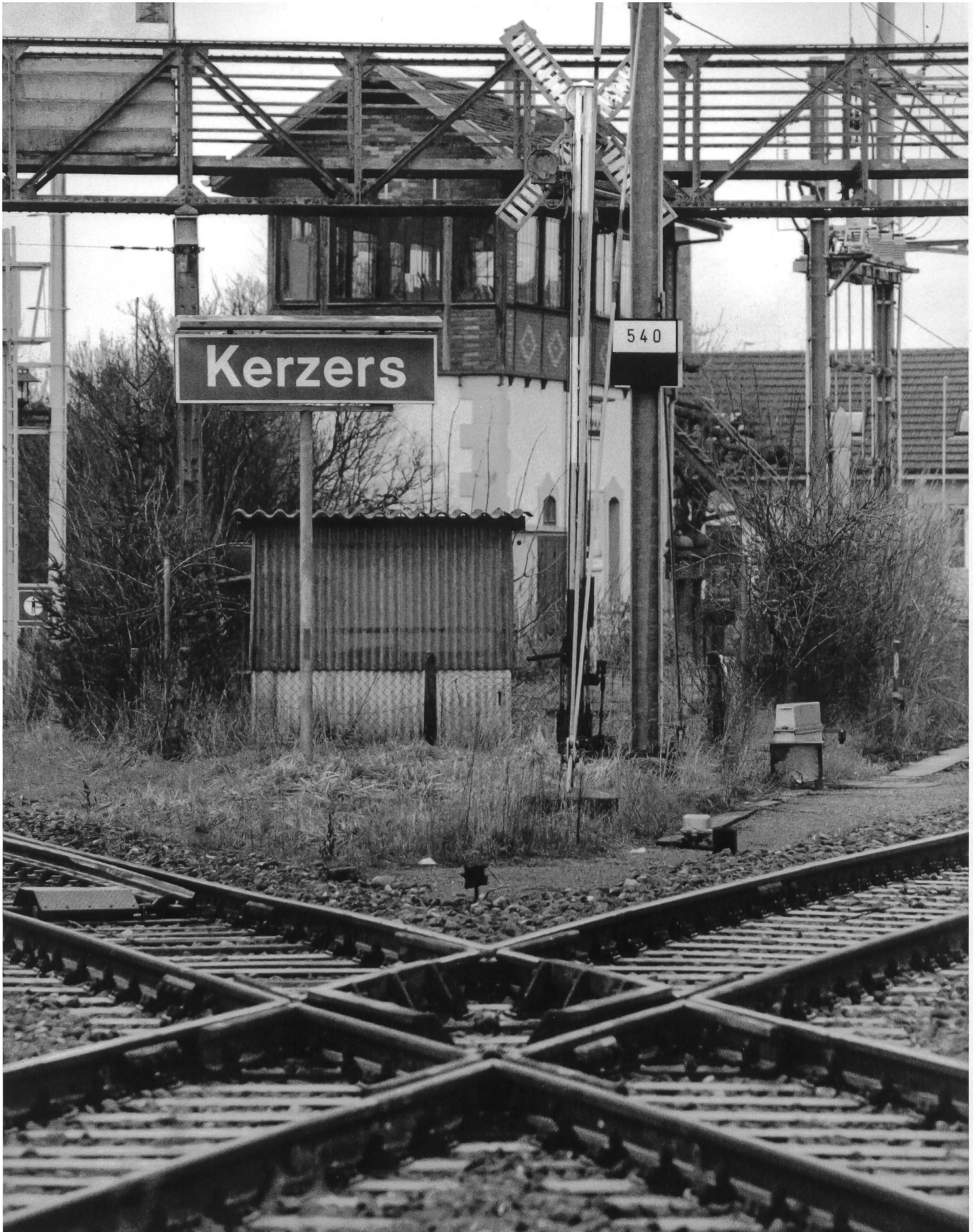
Seit 1901 kreuzen sich im Bahnhof Kerzers die Linien Lausanne-Lyss und Bern-Neuenburg. Wegen der besonderen Betriebsbedingungen und Eigentumsverhältnisse ist das Stellwerkgebäude von 1896 mit seinen Einrichtungen trotz ständigen Anpassungen an neue Sicherheitsstandards erhalten geblieben. Zum Ensemble gehören die eiserne Passerelle und das noch immer mit Drahtzug bediente Rangiersignal, mit dem der bahnhofinterne Verkehr geregelt wird. Dessen Balken in Kreuzstellung zeigen, dass zum Zeitpunkt der Aufnahme nicht rangiert werden durfte. Siehe S. 52-55.
