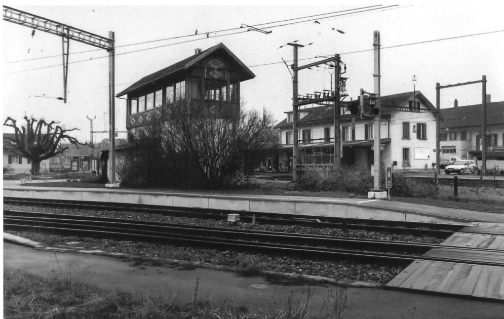
Abb. 1 Bahnhof Kerzers. Im Vordergrund die Gleise der Bern-Neuenburg-Bahn, in der Bildmitte das Stellwerk (1896/1928), rechts, an der Linie nach Lyss, das Aufnahmegebäude (1876/1901) unter dessen Vordach das Befehlswerk steht; ganz links eine Rosskastanie der Platzanlage zwischen beiden Geleisegruppen.
