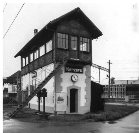
Abb. 4 Das 1896 erbaute und 1928 erweiterte Stellwerk im Dreieck zwischen den beiden Bahnlinien. Hinten links das Unterwerk von 1924. Siehe auch S. 4.
