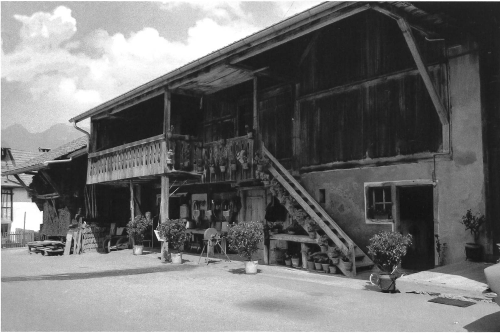
Fig. 1 L'immeuble Chemin du Grenier 8 à Grandvillard. Façade sur rue avant transformation.
