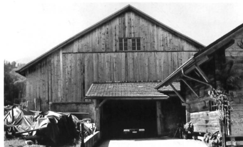
Fig. 2 Façade pignon avant transformation.
