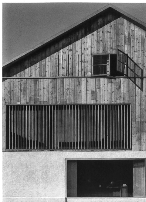
Fig. 4 Façade pignon après transformation. L'ancienne fenêtre est conservée, le percement de l'ancienne remise au rez-de-chaussée est fermé de manière franche par une grande baie vitrée. Les planches du bardage ont été adaptées en lames mobiles.
