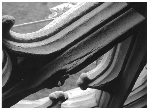
Fig. 17 et 18 Remplages présentant un délitage de la molasse. Abb. 17 und 18 Masswerke mit aufbrechenden Lagern.
