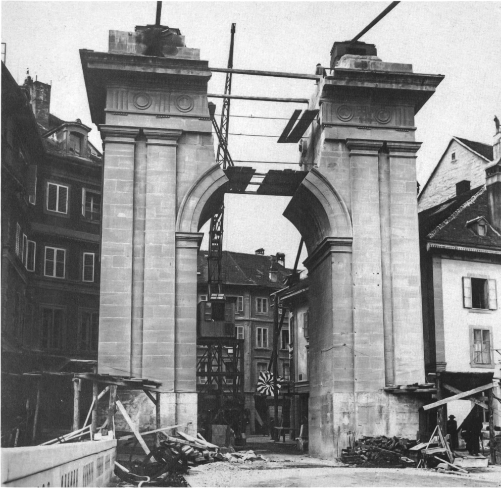
Fig. 9 Mai 1924, démolition du portique sud du Grand Pont suspendu, dont les blocs de molasse furent transportés à Gambach comme matériau pour la nouvelle église Saint-Pierre. On distingue déjà à gauche le garde-corps en béton du nouveau pont de Zähringen (BCUF, Fonds Johann & Jean Mülhauser).
