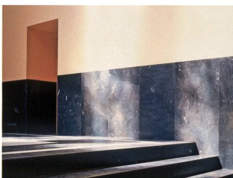
Fig. 127 Sol et mur du chœur après réaménagement, 2003 : pierre bleue de Belgique, enduit lisse et peinture silicate.
