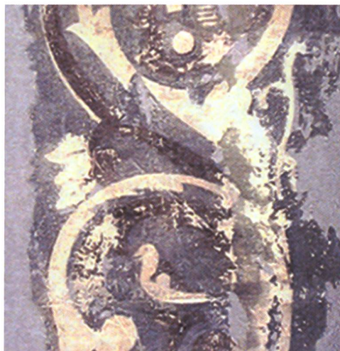
Fig. 144 Rinceaux à l'intrados des arcs de la nef, état avant intervention avec altération des repeints de 1970 et apparition de la couche originale sous-jacente.
