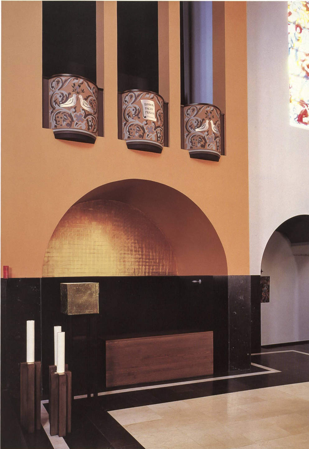
Fig. 142 Travée de chœur après reconstitution de l'ocre orangé du mur, sur l'assise en pierre bleue de Belgique, avec niche dorée et premier balcon avec décor original en partie dégagé sous la couche de 1970.
