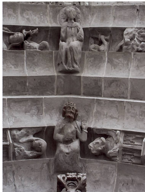
Abb. 100 Der Scheitel der Archivolten nach der Restaurierung, Herbst 2016.
