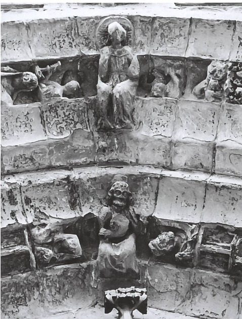
Abb. 99 Der Scheitel der Archivolten, Zustand vor der Konsolidierung.
