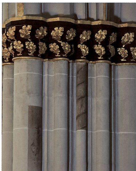
Fig. 144 Troisième pilier sud de la nef avec vestiges de peinture médiévale dont un Calvaire tout à gauche et une torsade polychrome sur l'une des colonnettes.
