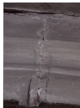
Fig. 145 Détail de l'arc doubleau séparant la 2 e et la 3 e travée du collatéral nord, avec rare témoin du décor de faux-joints médiéval, composé d'un filet rouge entre deux filets noirs.
