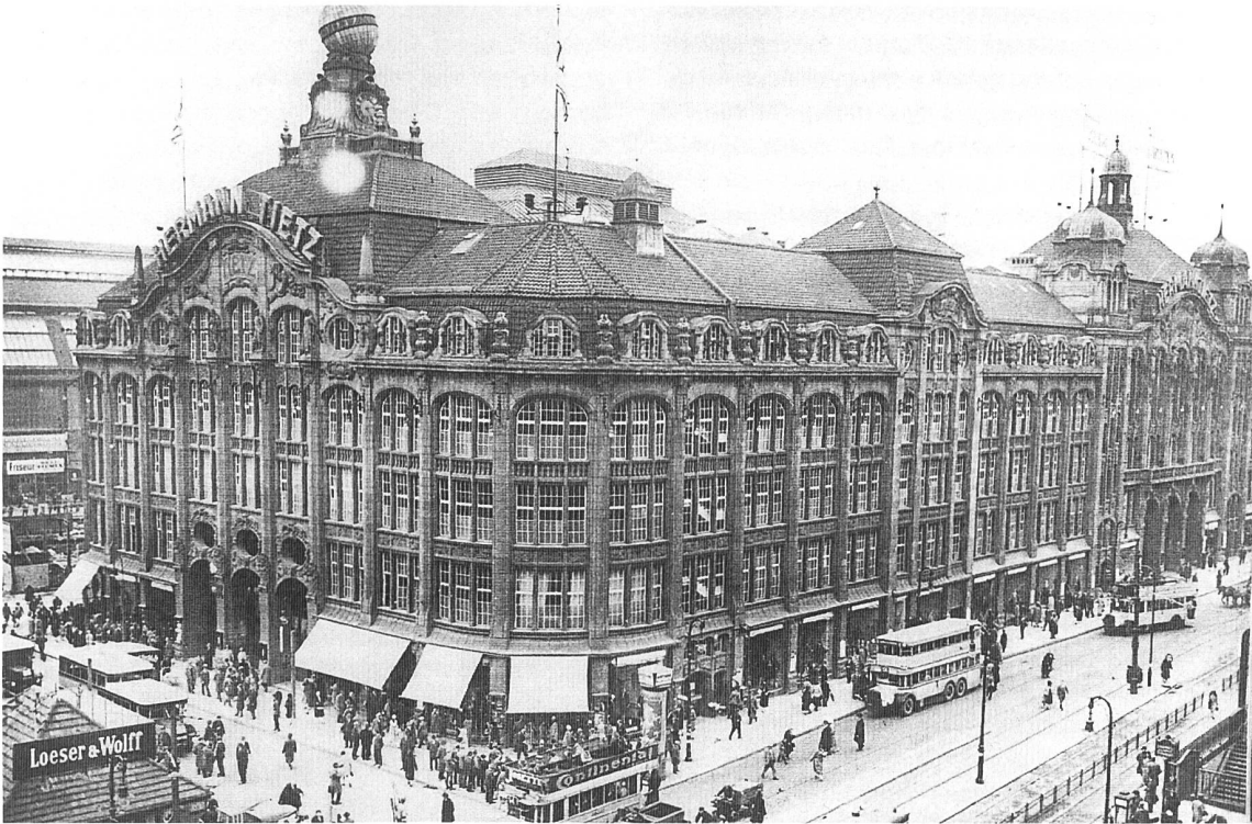
Aussenansicht des Warenhauses Tietz am Alexanderplatz (Quelle: Frei 1997, S. 83)
