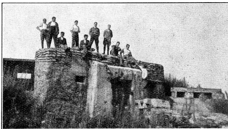
Photo No. 2: Tête des Faux, Festungsanlagen auf dem Gipfel (1219 m). (Phot. R. Schoop.)
