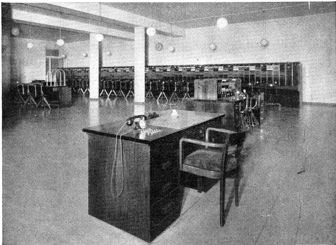
. Fern- und Schnelldienstplätze, Meldeplätze mit Rohrpostverbindung, Aufsichtspult und Oberaufsichtspult.
