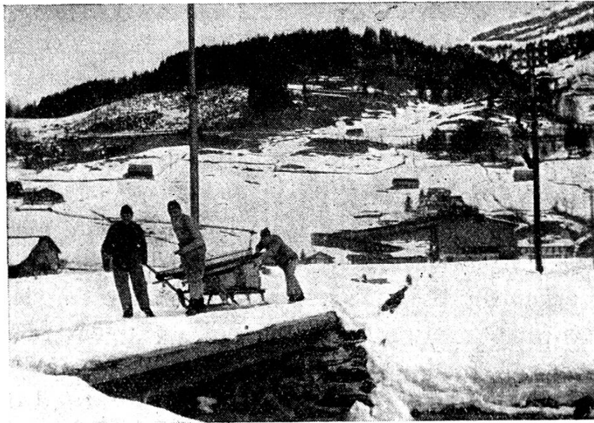
Materialtransport auf dem «Kabelschlitten» nach Gerschnialp.
