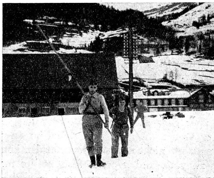
Kabellinienbau für das Slalomrennen Hegmatt—Engelberg.
