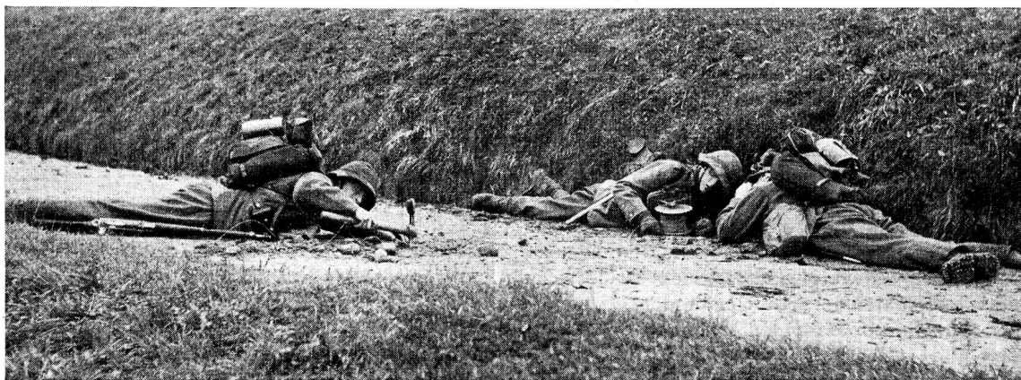
Die Aufgabe des Telephonsoldaten beim Leitungsbau ist hart. Hier pickelt er eine Furche in den Strassenboden, in der das Kabel die Feldstrasse kreuzt.
