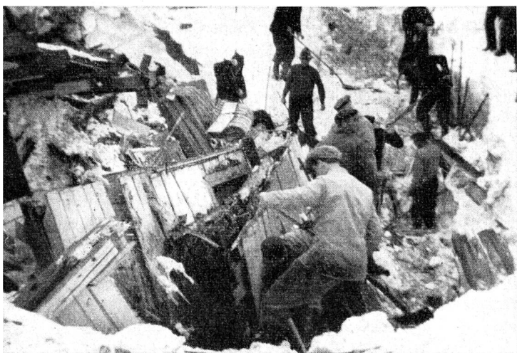
Grauenhaft ist das Bild verwüsteter Städte. Der Zivilschutz kann weder Krieg noch Bombardierungen vermeiden, aber wenn die Bevölkerung weiss, wie sie sich bei Luftangriffen zu verhalten hat, so können die Verluste reduziert werden.
