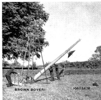
Aufbau des Antennenmastes
