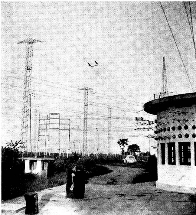
En haut: Démolition d'un point de transition. Au milieu: Ligne aérienne Léopoldville–Matadi; cabine pour point de coupure (utilisée comme débit de vin de palme). En bas: Centre d'émission radio au beam à Léopoldville, à droite l'entrée d'antennes au beam.
