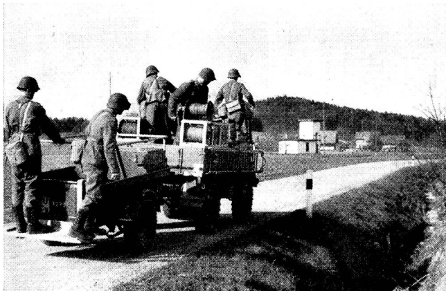
Die sorgfältige Beurteilung des Geländes durch den Fahrer eines Baufahrzeuges und entsprechend zweckmässiges Fahren des Unimogs tragen dazu bei, der Baugruppe die Arbeit zu erleichtern.
