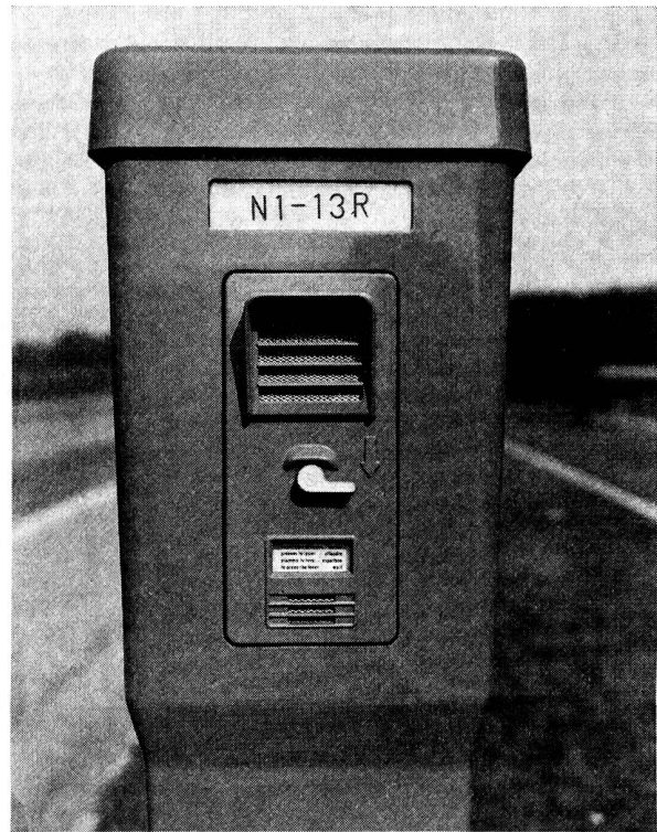
Fig. 5 Ruf- und Sprechersatz einer Notrufsäule
