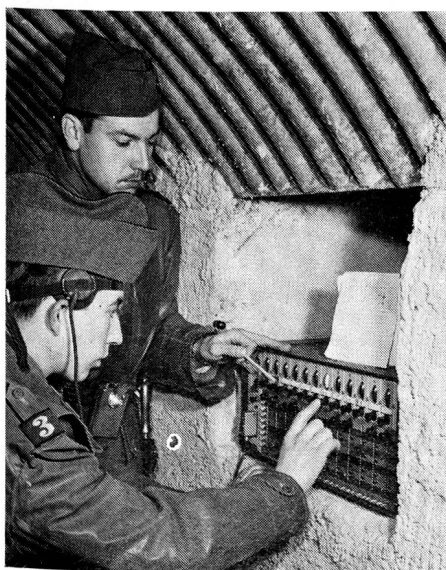
Die Feldtelefonzentrale im sicheren Unterstand des Abwehrraumes
