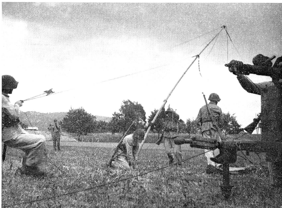
Schweiz. Unteroffizierstage 1952 in Biel: Mit vereinten Kräften beim Antennenbau FL 40 Journées de l'ASSO à Bienn 1952. Montage d'un mât de la FL 40 (SE-300).
