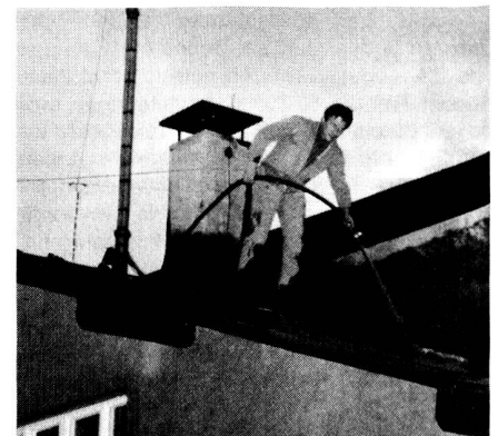
Der Präsident beim Dachreinigen
