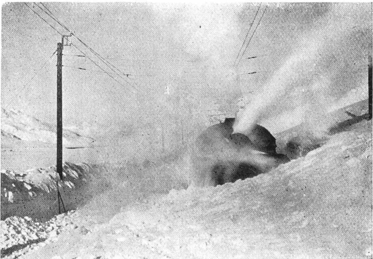
Schneeschleudermaschine an der Arbeit.
