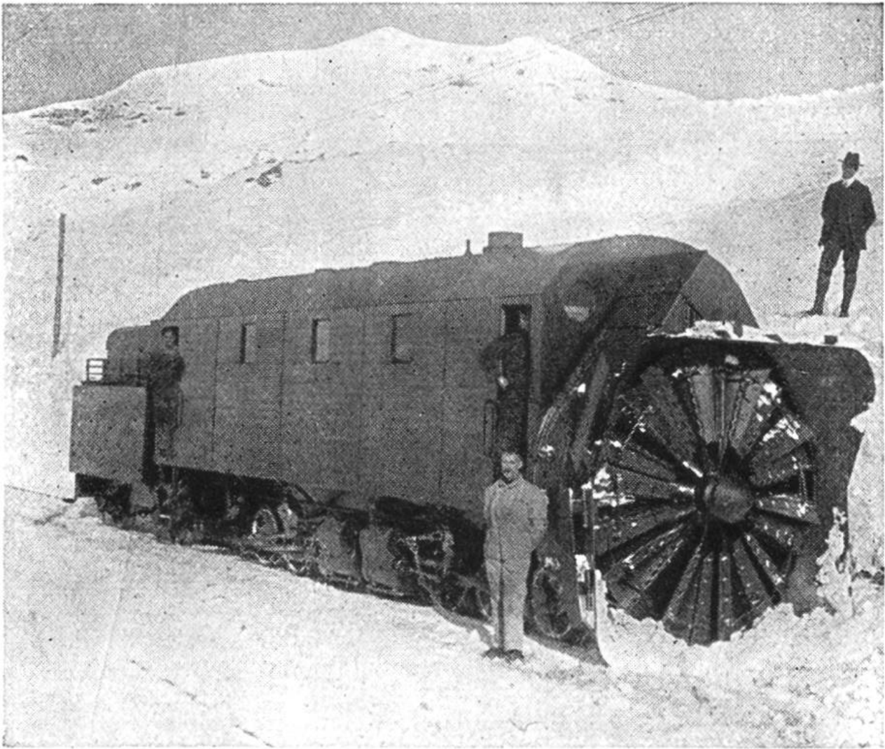
Die Schneesleudermaschine der Berninabahn vor einer mehr als mannshohen Schneemauer.
