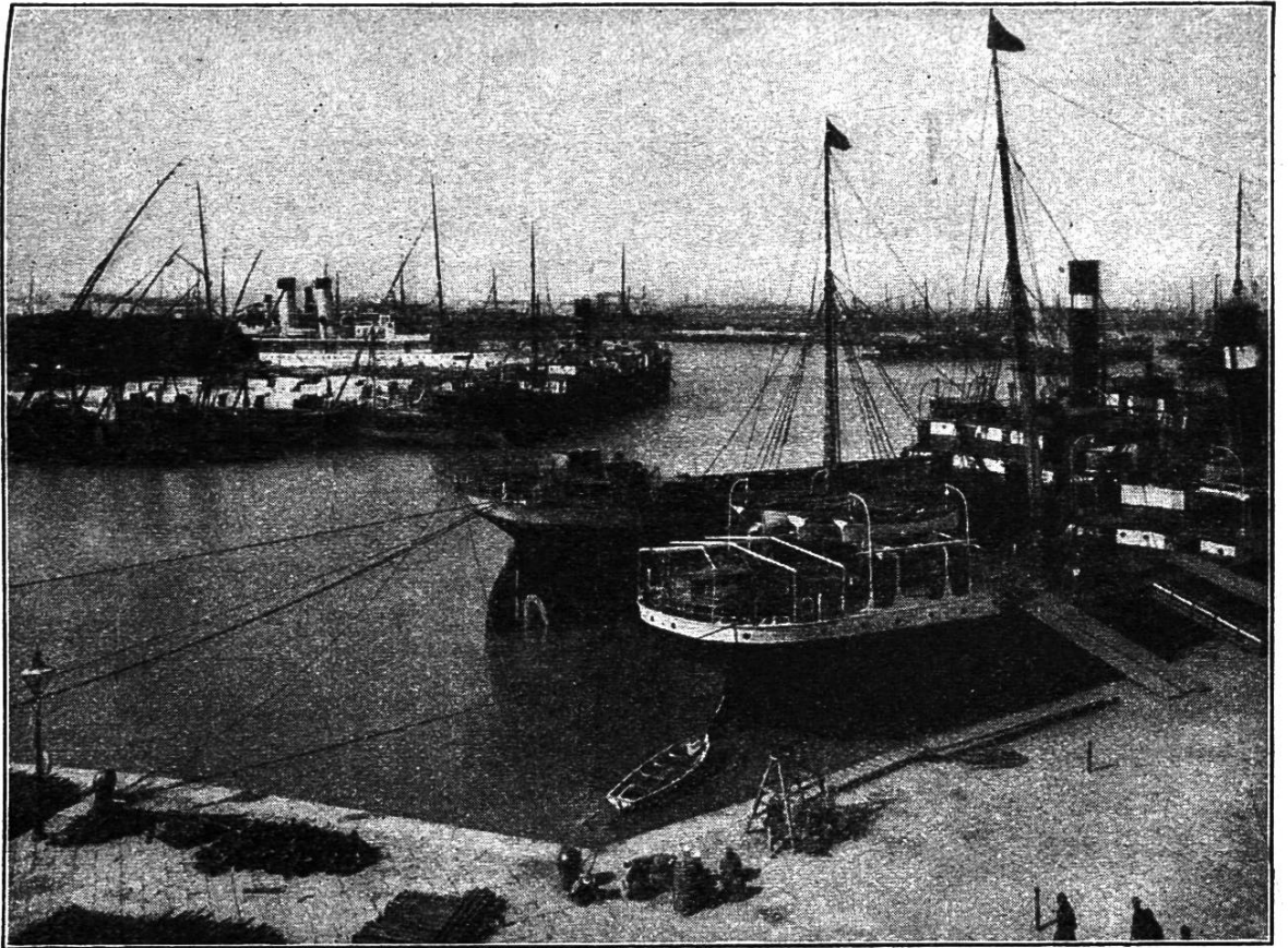
Hafen von Alexandria. Alexandria ist die wichtigste Handelsstadt von Ägypten. In dem groß angelegten Hafen wird auch ein bedeutender Teil der Baumwolle, welche die Schweiz verarbeitet, verschifft. (1922=684,000 Ballen ägyptische Baumwolle.)
