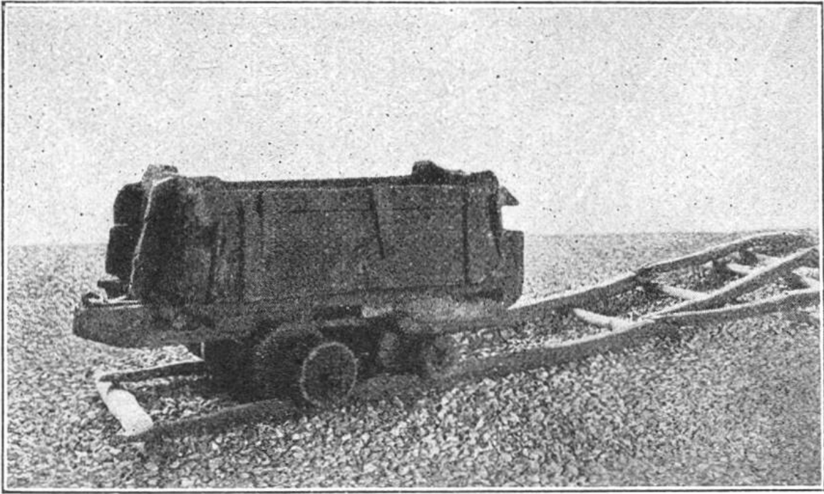
Erstmalige Anwendung von Schienen. Original-Kohlenfarren aus einem mittelalterlichen deutschen Bergwerk.
