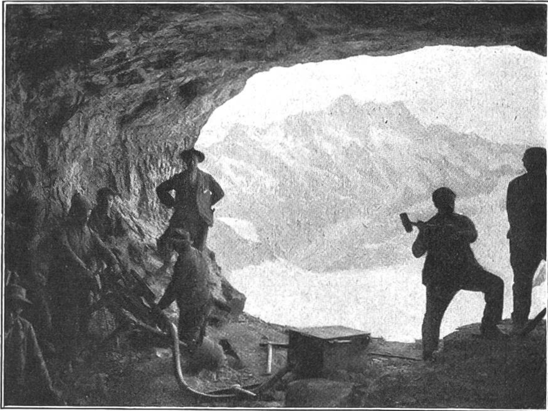
Tunnelbau an der Jungfraubahn. Rechts: die alte Bohrweise mit Meißel und Zuschlaghammer; links: moderne Bohrmaschine mit Preßluft.
