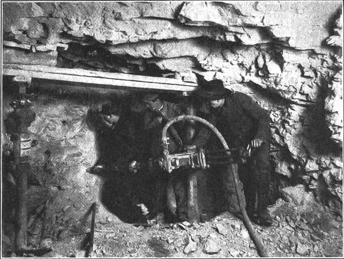
Handbohrmaschine bei Tunnelbau. Die Bohrlöcher werden mit einer Sprengladung gefüllt. Die Gewalt der Explosion sprengt Stücke vom Felsen weg.
