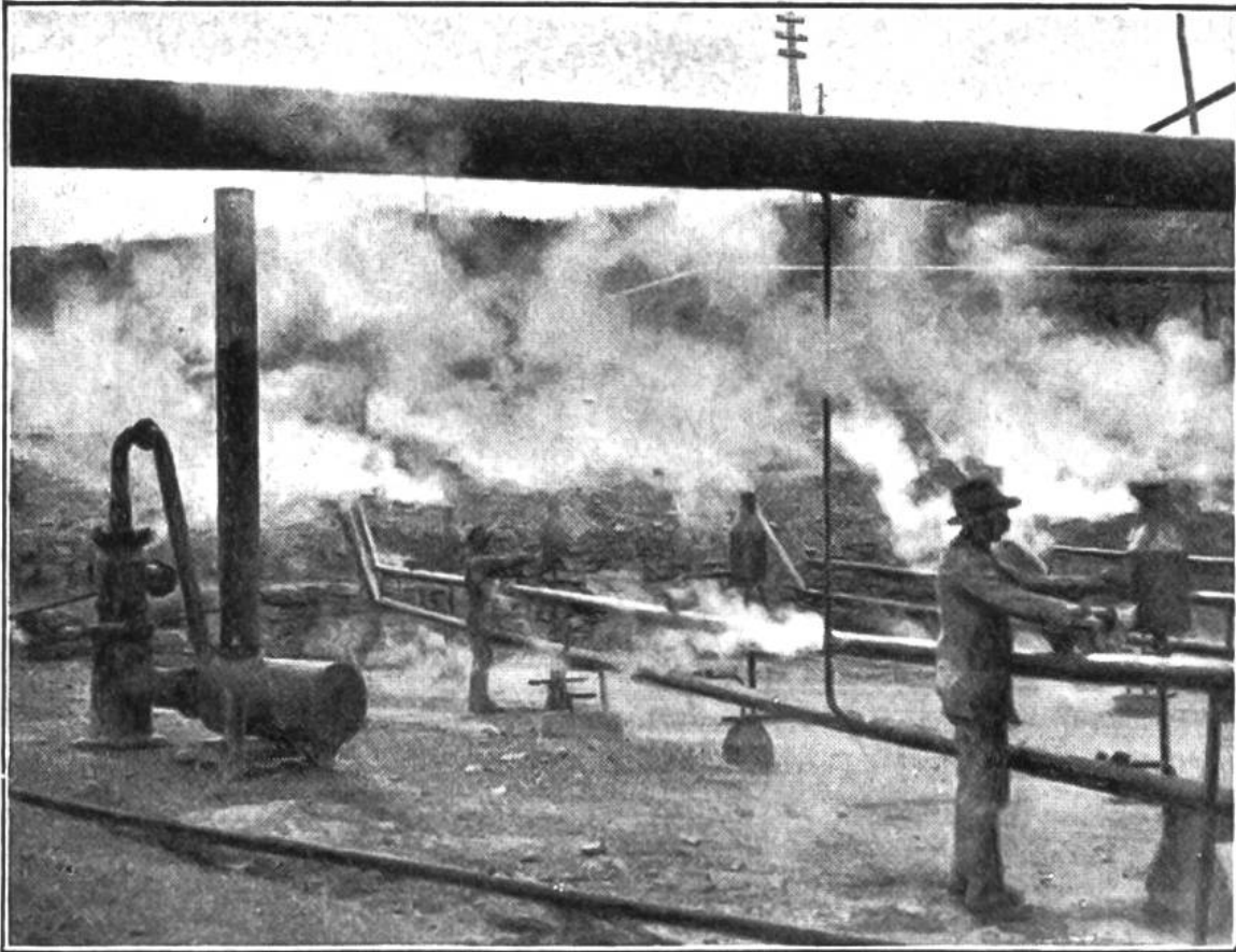
E i n e S t a t i o n , an der die mit Dampf gefüllten Rohre zusammenlaufen.
