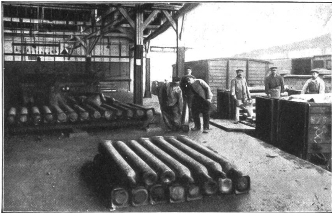
Grosse Stahlzylinder, welche die Pressluft enthalten, werden verfrachtet.
