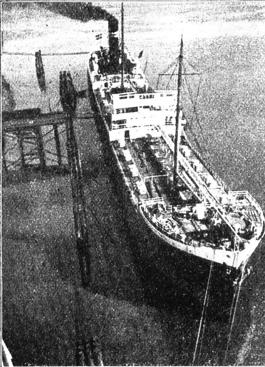
Ein Dampfer, der rohes Erdöl von Südamerika nach Europa bringt. Vom Schiff aus wird die wertvolle Flüssigkeit in riesige eiserne Behälter nahe dem Anlegeplatz gepumpt.
