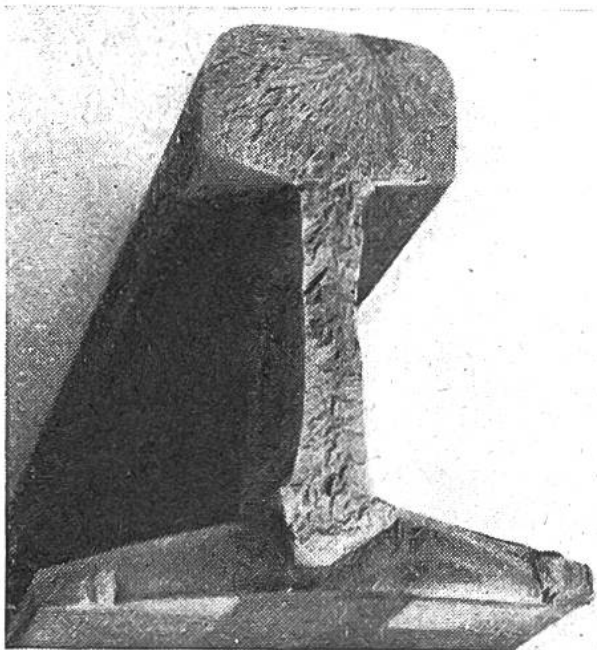
Abb. 8: Dauerbruch einer Schiene.
