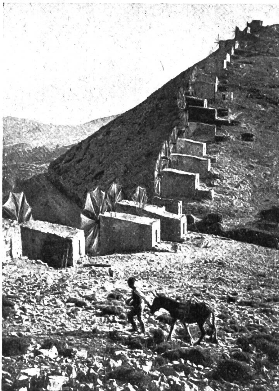
Der „Pass der dreissig Windmühlen“ auf der griechischen Insel Kreta. – Die Windmühlen treiben Pumpen, die während des Sommers das trockene Land mit Wasser versorgen.
