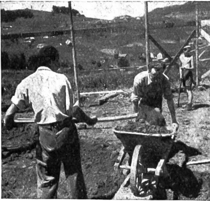
Junge freiwillige Helfer beim Ausheben der Baugrube.
