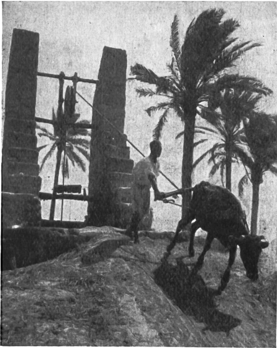
Ein Ochse dient als ‚Zugtier‘, um Wasser aus der Tiefe des Ziehbrunnens einer Oase bei Tripolis zu schöpfen.
