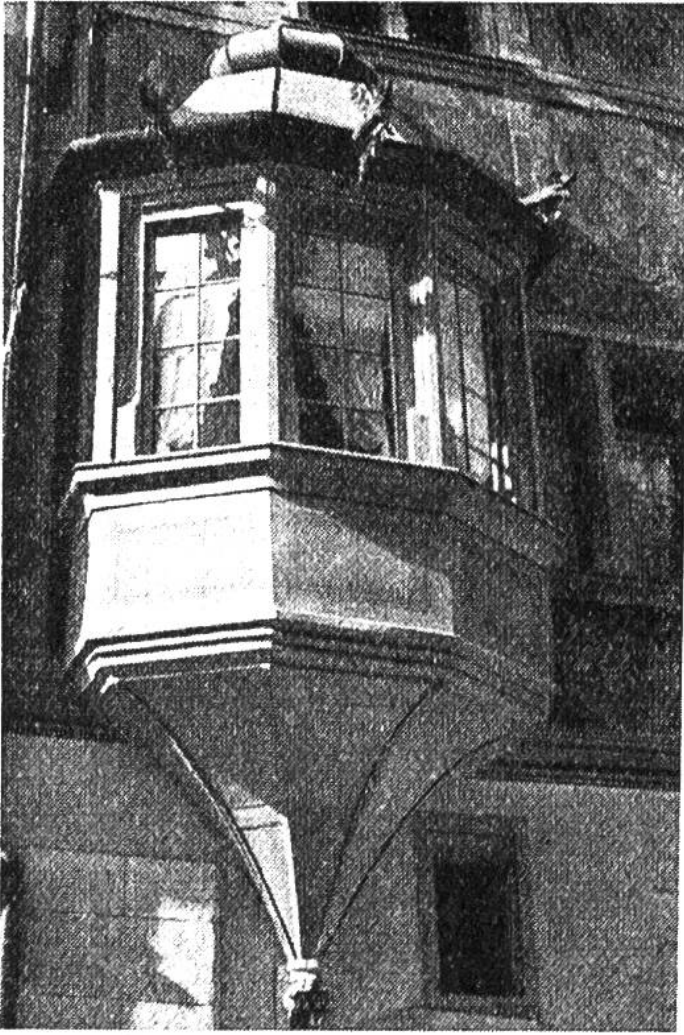
Erker am Haus „zum Ritter“, Schaffhausen, mit elegant geschweiftem Dach, 1566 entstanden. Damals schmückte Tobias Stimmer die Fassade mit seinen berühmten Malereien (19. J. genau nach dem Original erneuert).
