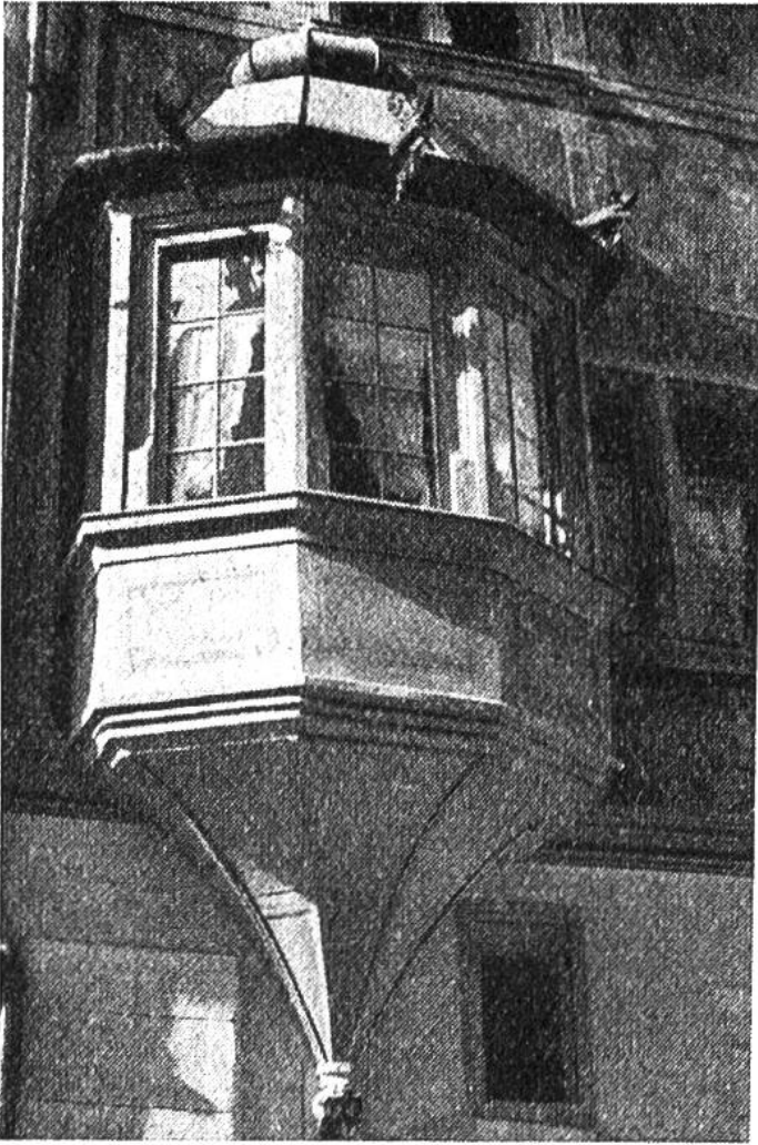
Erker am Haus „Zum Ritter“, Schaffhausen, mit elegant geschweiftem Dach, 1566 entstanden. Damals schmückte Tobias Stimmer die Hausfassade mit seinen berühmten Malereien (1939 genau nach dem Original erneuert).
