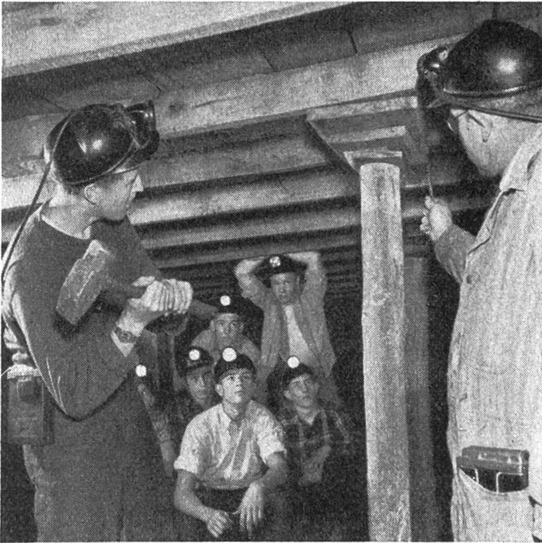
Eine Klasse der Bergmannsschule erlernt hier die Pölzung des Stollens mit Holzverschlägen, eine der wichtigsten Sicherungsvorkehrungen bei der Durchführung der Sprengungen.
