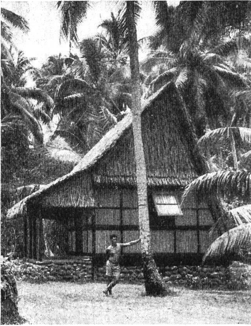
Modernes Haus mit Dach und Wänden aus Palmblattfiedern, in einer Pflanzung von Kokospalmen in Moorea auf der Insel Tahiti (Ozeanien).
