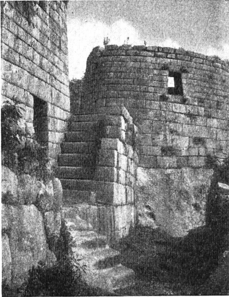
Die mächtigen Bauwerke der Inkafestung. Unten: Die berühmte runde Mauer von Machu Picchu.
