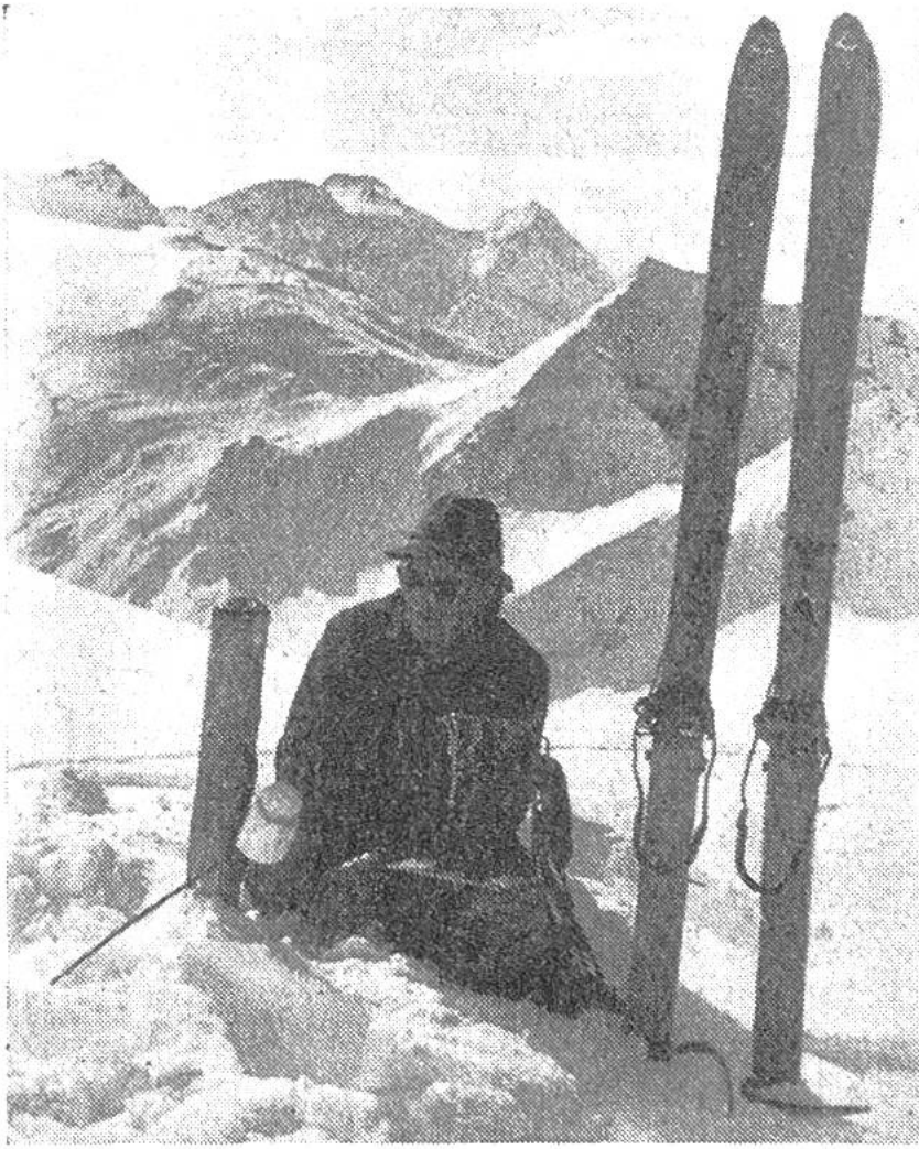
Sonnblickgipfel: Der Hüttenwart Hermann Rubisoier muss die bis zu den Isolatoren tief im Schnee versunkene Telephonleitung reparieren.
