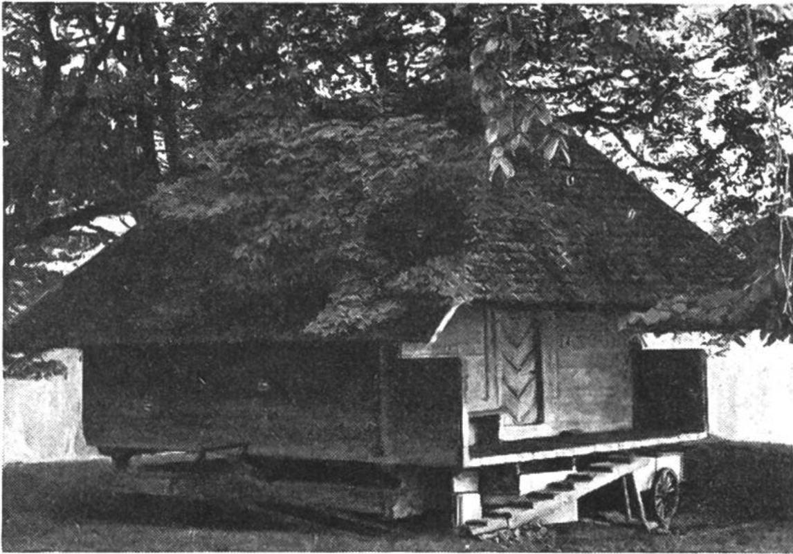
Käsespeicher auf dem Schallenberg aus dem Jahre 1779 im Schatten einer alten Baumgruppe, der Speicher einer einstigen «Herrenalp».
