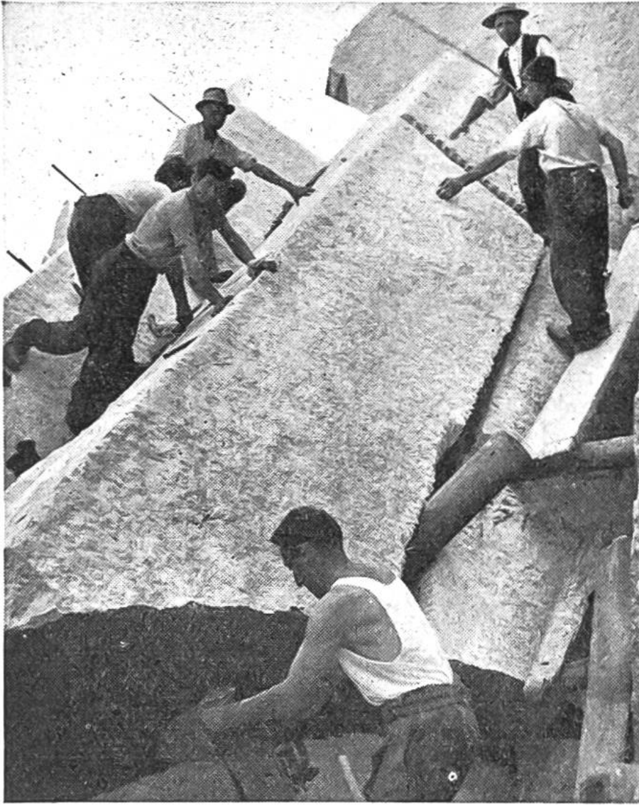
Steinbrecher beim Lösen des Steines vom Felsen.
