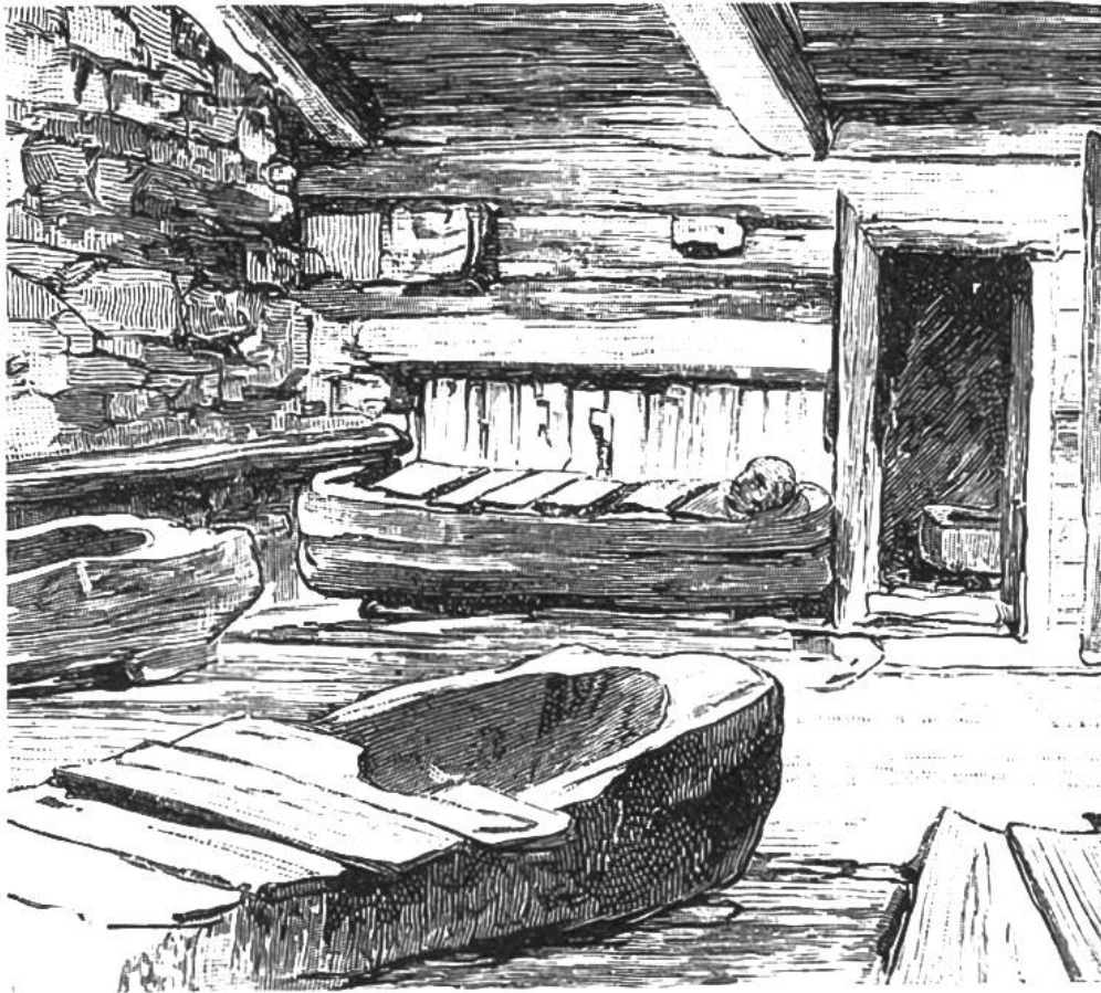
Badstube in Oberkärnten um 1880. Zeichnung von A. Heilmann. Die Badtröge bestehen aus ausgehöhlten Baumstämmen.
