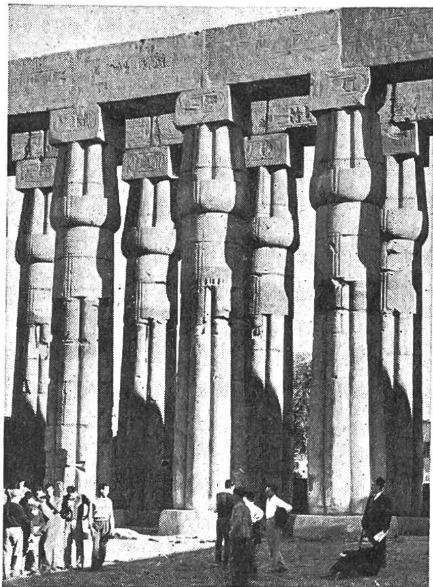
Die gewaltigen Säulen in einem Hof des Tempels von Luxor sind den Formen der Papyrus-Doldennachgebildet. Auch hier sind die Grössenverhältnisse Säule-Mensch eindrucklich.
