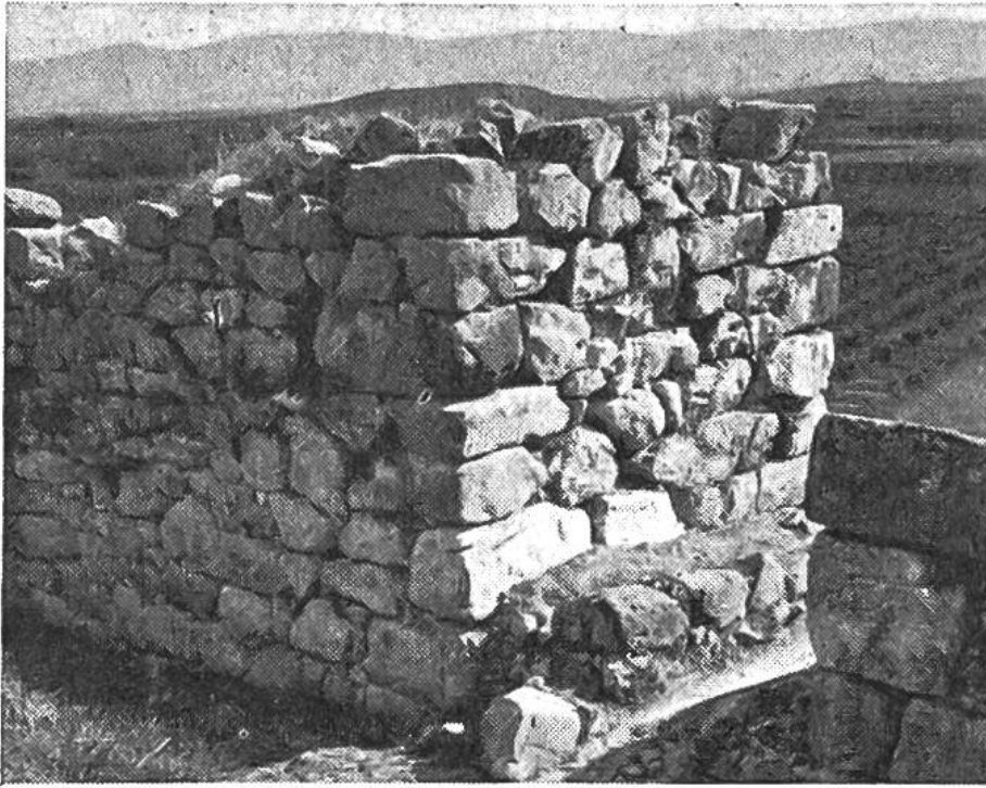
Blick auf die gefügte Umfassungsmauer der Burg von Tiryns. Eine Burg mit solchen Mauern war damals praktisch unbezwingbar.
