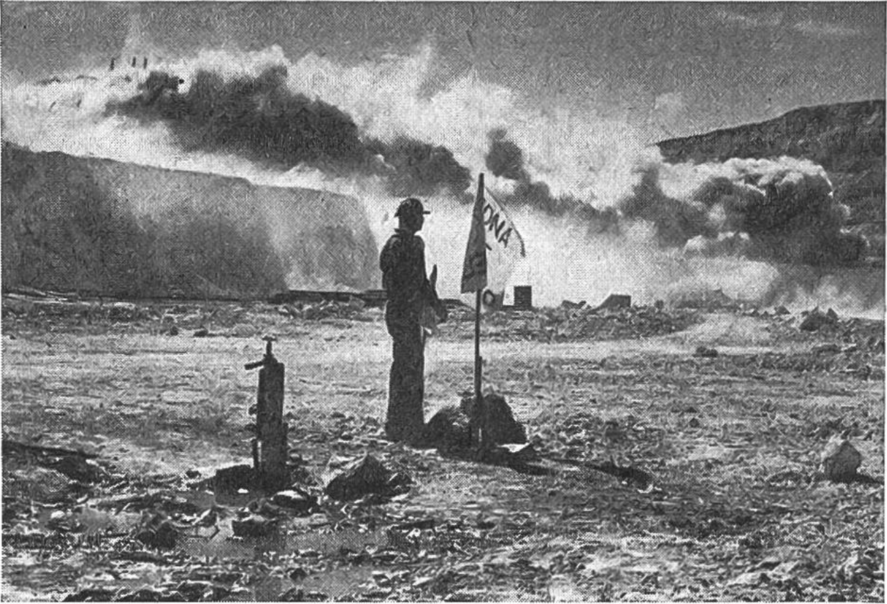
Das kupferhaltige Gestein wird losgesprengt.
