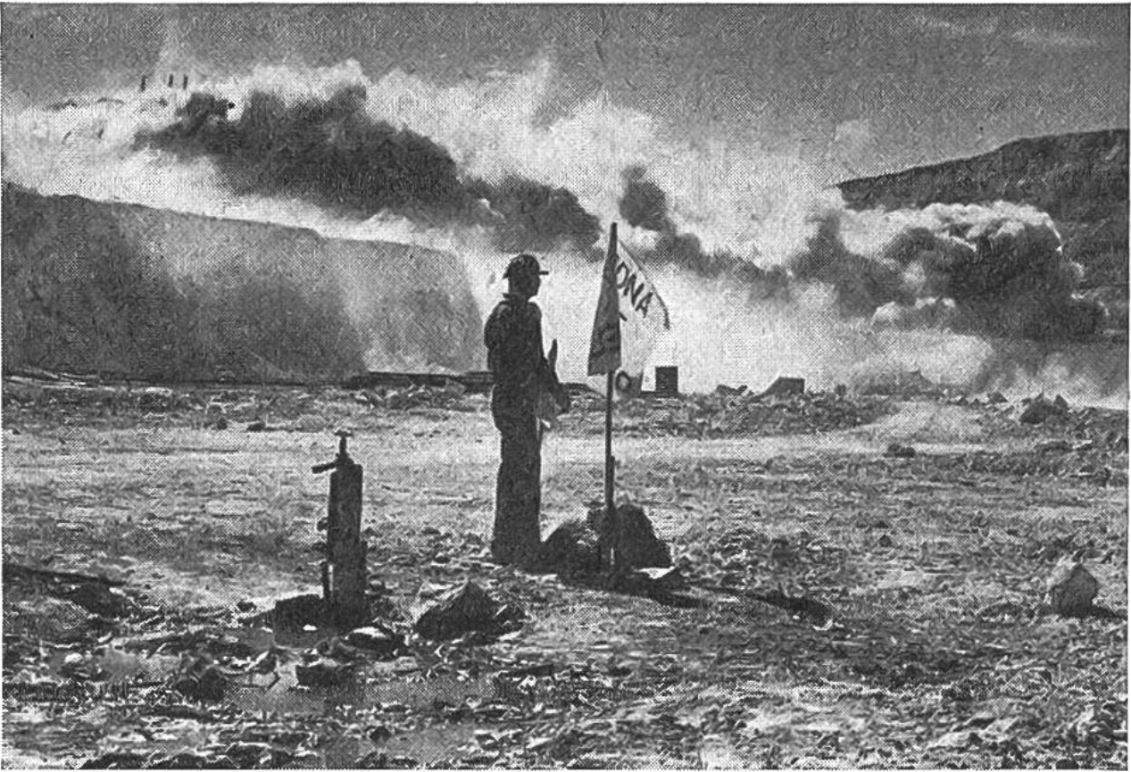
Das kupferhaltige Gestein wird losgesprengt.
