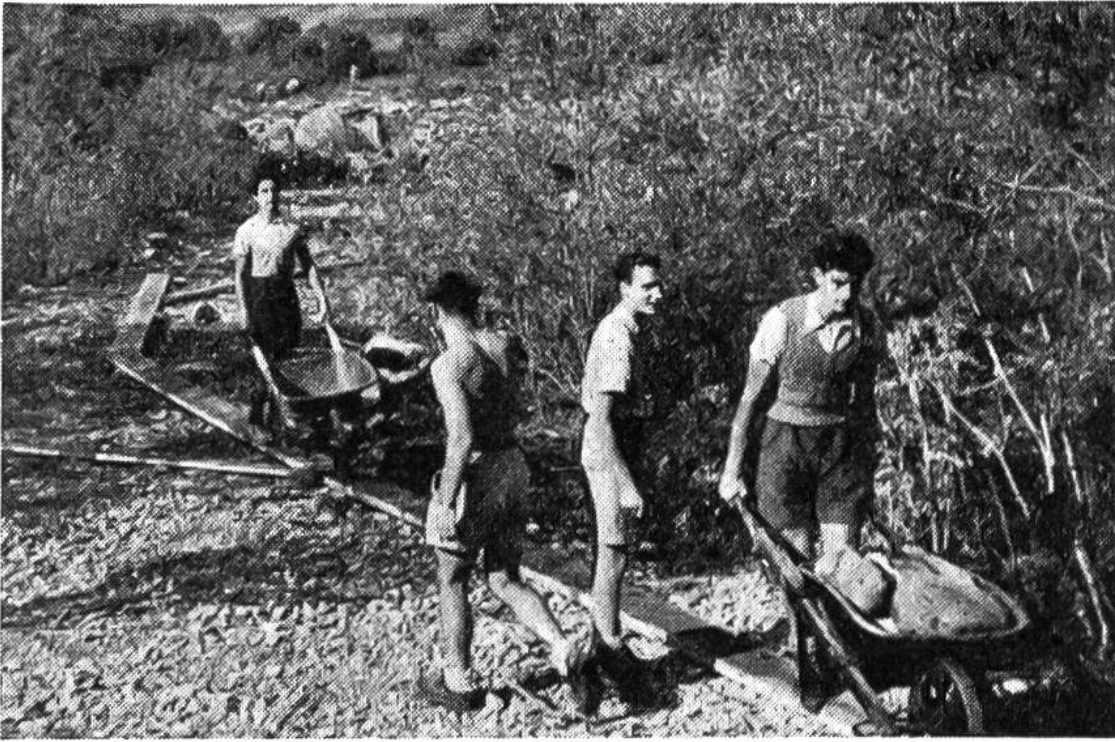
Der Sumpfboden wird aufgefüllt – nutzbringende Arbeit im Dienst einer ganzen Gemeinde.
