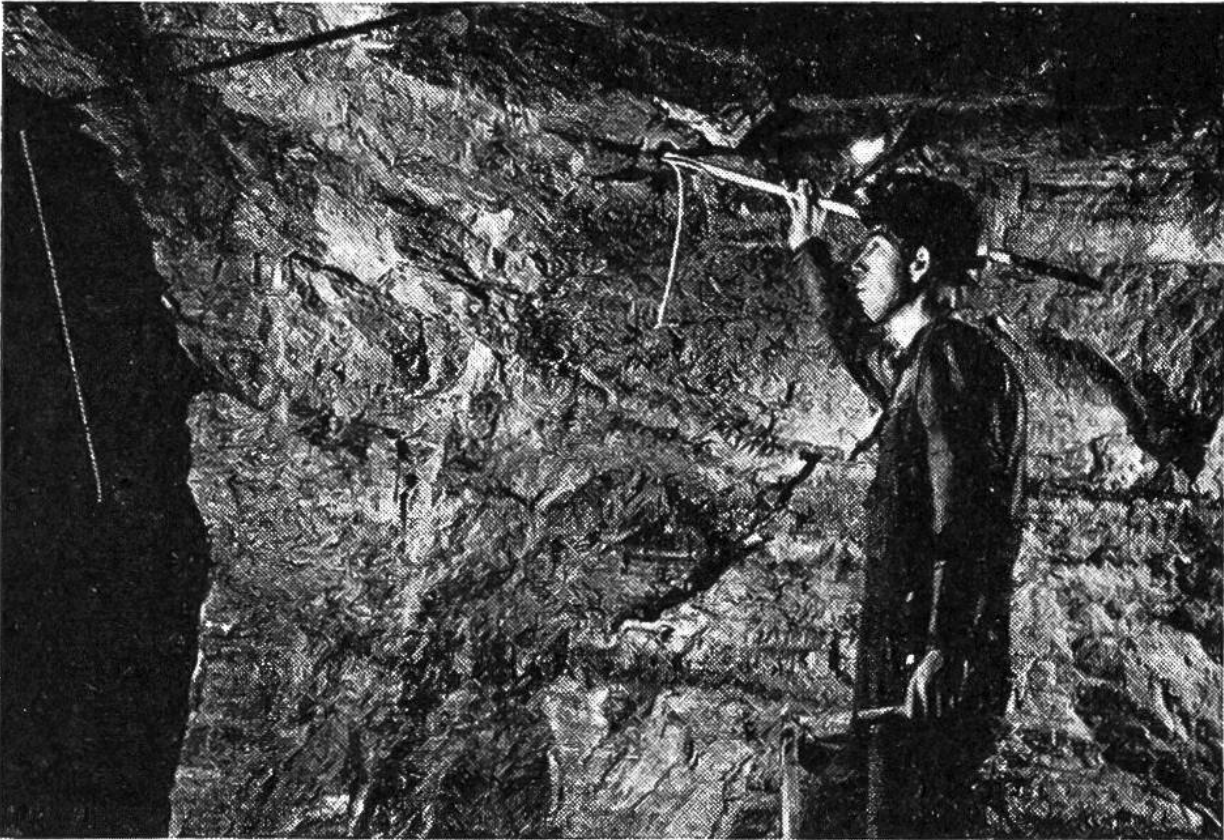
Ein Bergmann hat die Dynamitladung in das Sprengloch gebracht und stopft nach. Die Zündschnur ist deutlich sichtbar.
